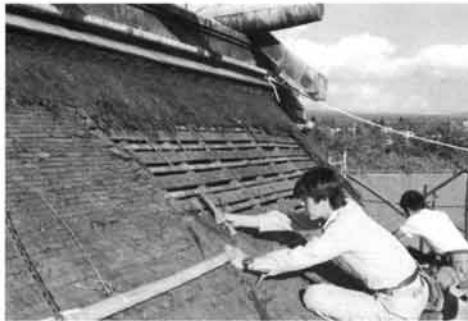
富士山本宮浅間大社本殿檜皮葺きの部分修理
